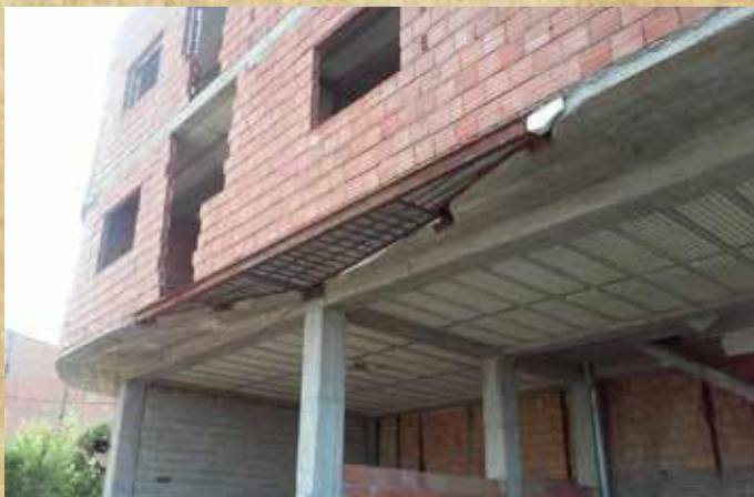
افزایش غیر اصولی سطح زیربنای ساختمان به صورت اتصال کنسول فلزی به کنسول بتنی
