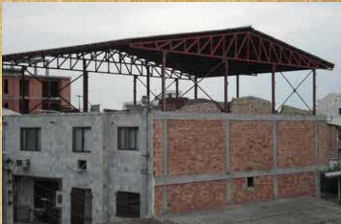
افزایش تعداد طبقات ساختمان به صورت اسکلت فلزی بر روی اسکلت بتنی
