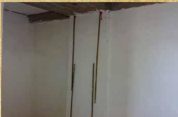
اجرای نامناسب مقاوم سازی پس از گچ کاری ساختمان
